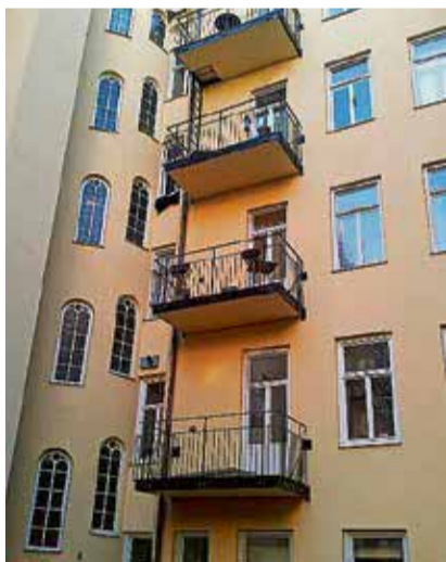
Tillbyggnad balkonger och nya fönsterdörrar
