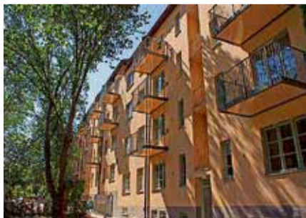
Fasadrenovering i samband med balkongbyggnation
