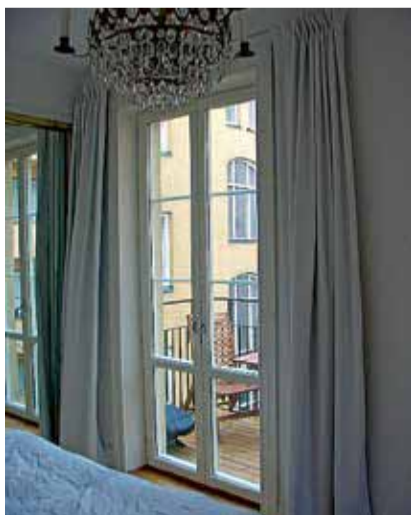
Ändring av fönster till fönsterdörr, vid tillbyggnad av balkonger
