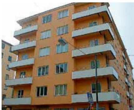
Vi renovera balkonger och monterar nya räcken
